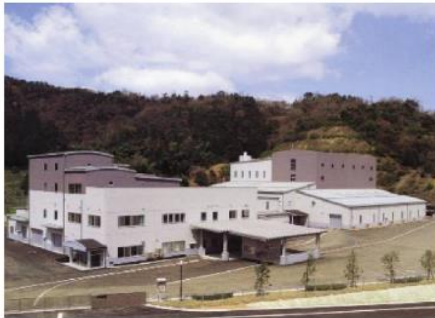
Figura 13: Imagen de la instalación comercial de gasificación por plasma de Mihama-Mikata (Fuente: Westinghouse Plasma Corporation, 2013)
