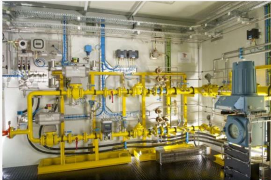
Figura 38: Estación de inyección de hidrógeno a red de gas (Fuente: Espinoza et al., 2021)
