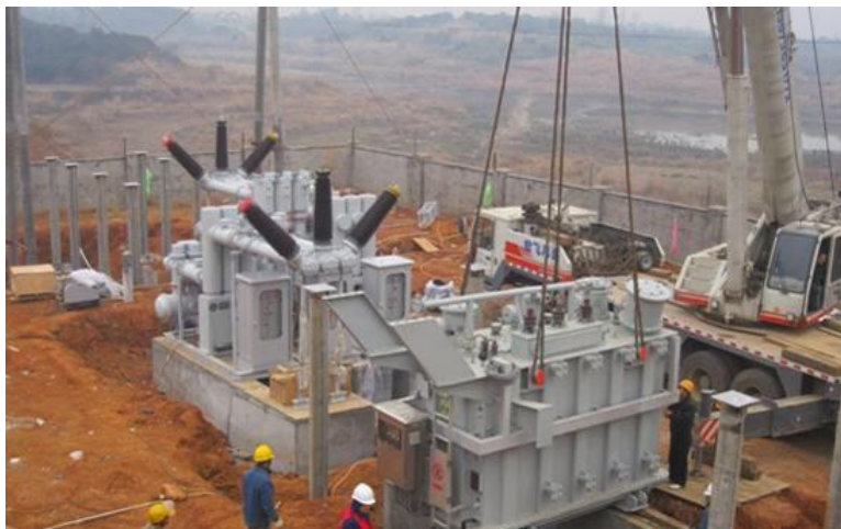
Figura 21 Instalación de una subestación encapsulada
