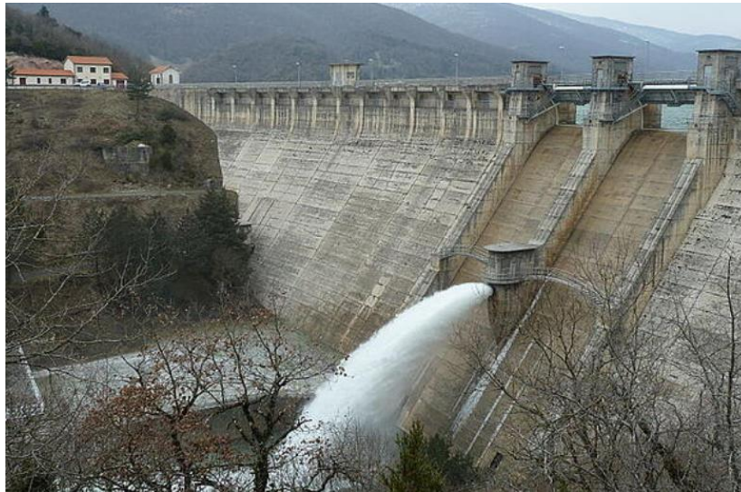
Figura 15 Presa con perfil triangular
