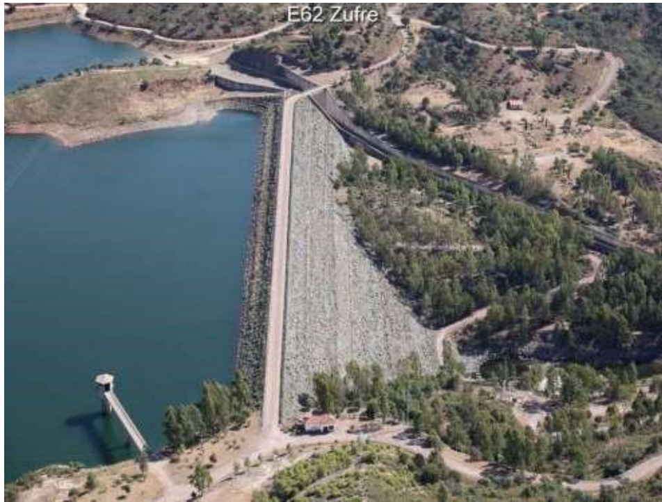
Figura 1 Presa de materiales sueltos
