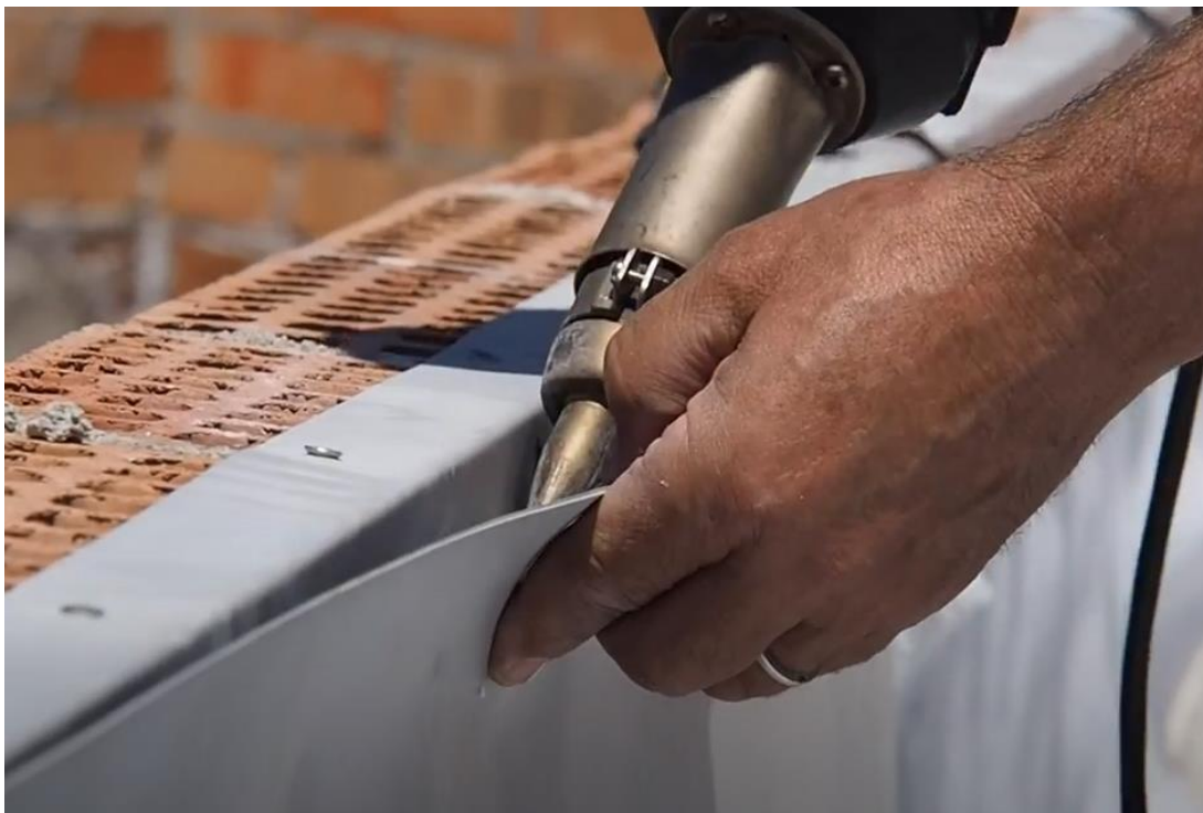
Figura 36 Unión entre panel y barra
