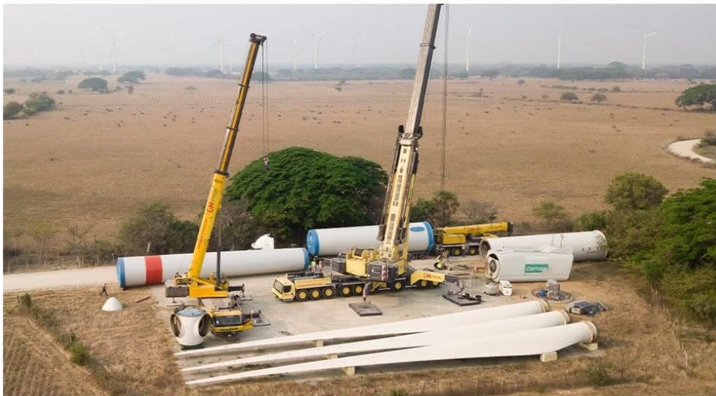
Figura 24: Plataforma de montaje, grúas y componentes del aerogenerador (geea.es)
