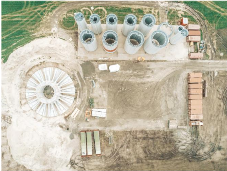
Figura 28: Cimentación Anker montada y elementos del aerogenerador (anker-foundations.com)
