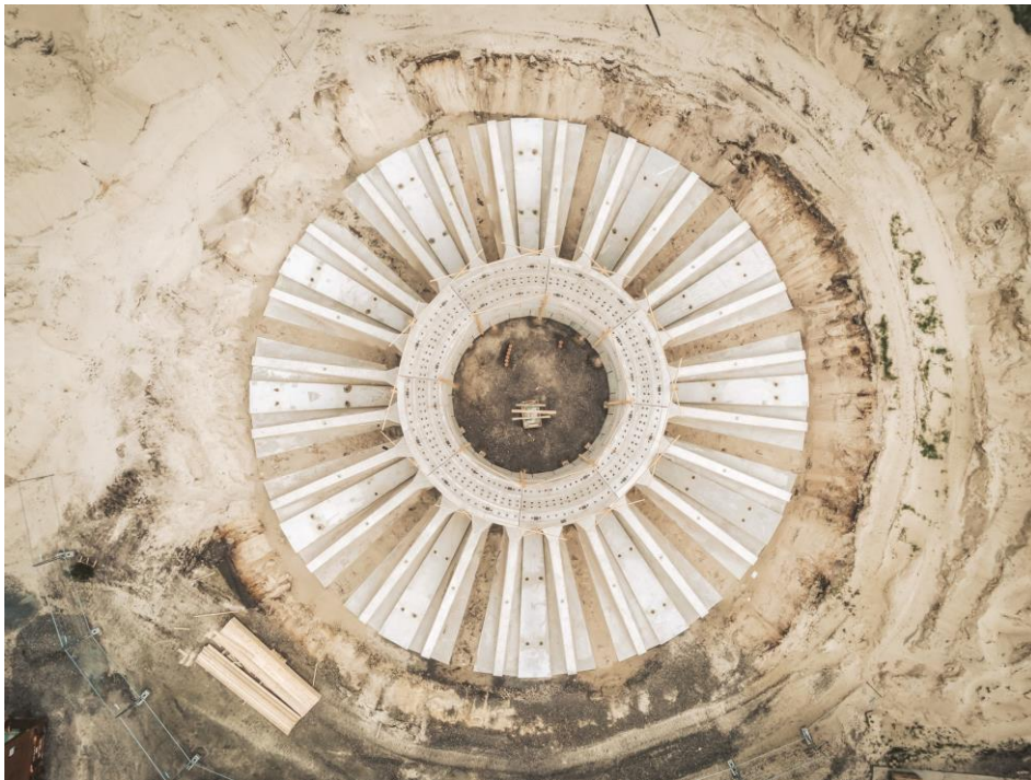
Figura 19: Cimentación Anker finalizada sin la capa de tierra que la cubre (anker-foundations.com)
