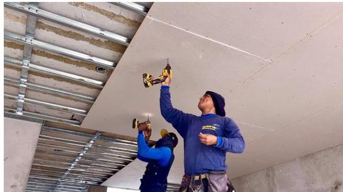
*Ilustración 4 – Instalación de paneles de yeso*
