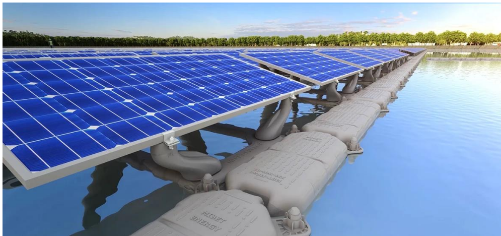
Figura 13. Disposición final de los paneles flotantes.
