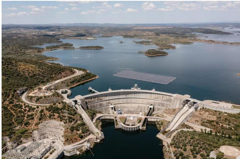
*Figura 24: Instalación fotovoltaica flotante del embalse de Alqueva (pv magazine España)*
