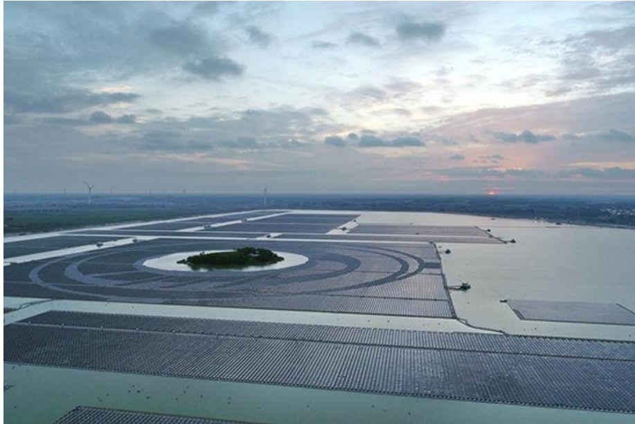
Ilustración 5 Instalación fotovoltaica flotante en Dezhou, China. (Huaneng Power International)
