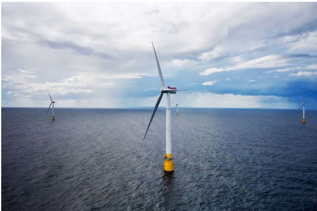
Figura 23. Estructura de soporte flotante Spar usada en granja eólica marina [22] [23]
