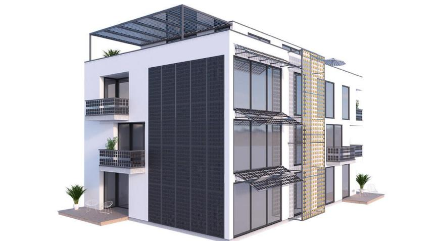
**Fig. 7** | Ejemplo de BIPV
