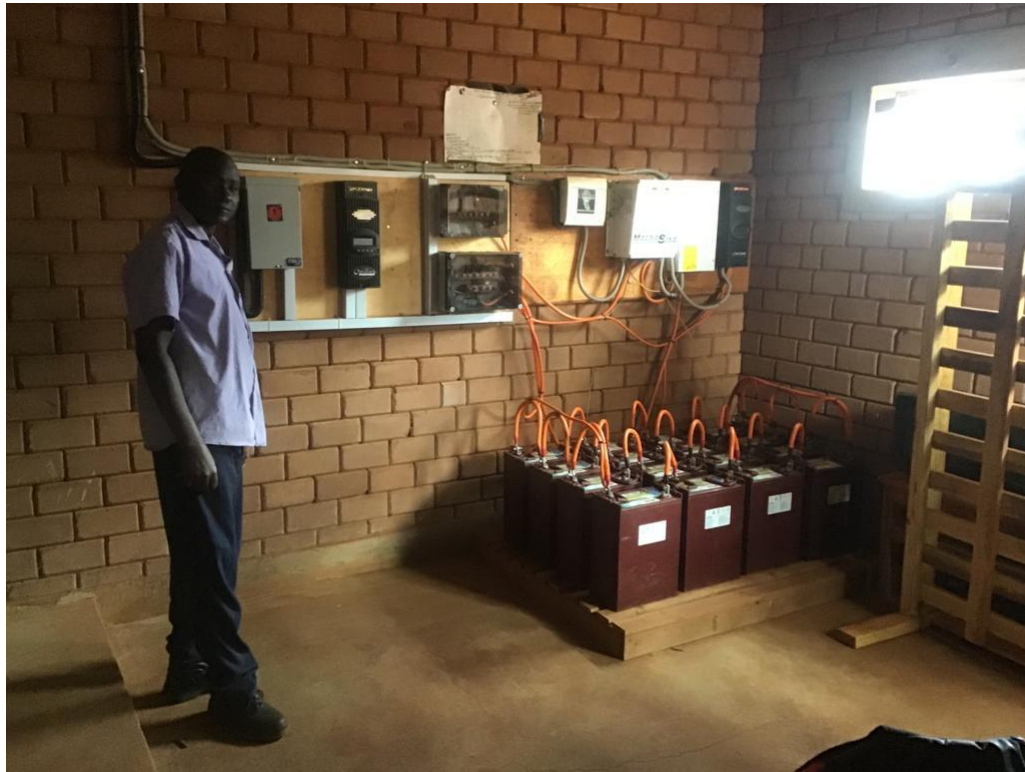
Figura 25: Instalación del High School
