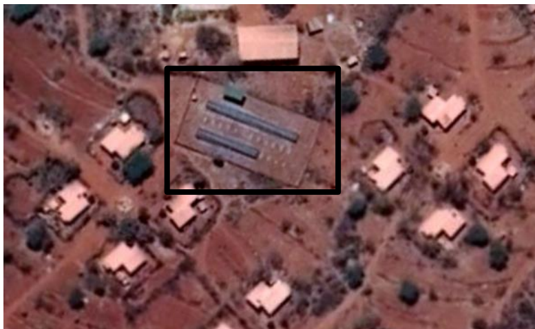
Figura 20: Huerto solar instalado en Nyumbani. Fuente: Energía Sin Fronteras
