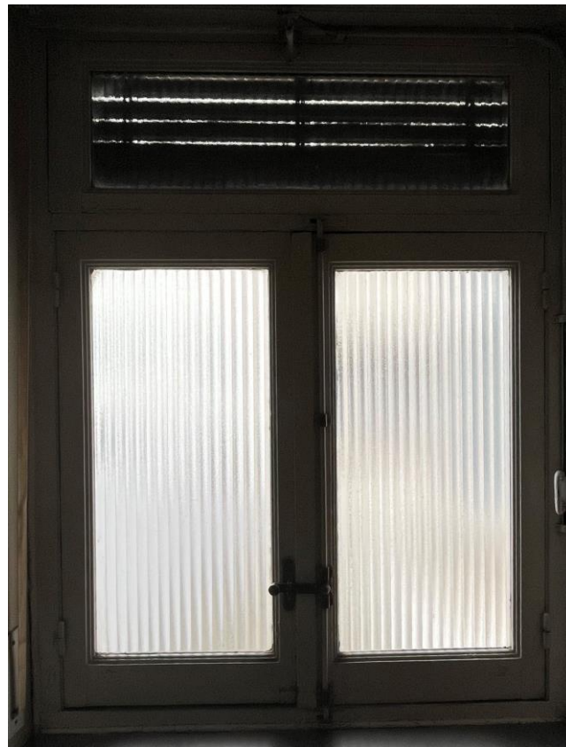
Figura 42. Ventana actual de la vivienda
