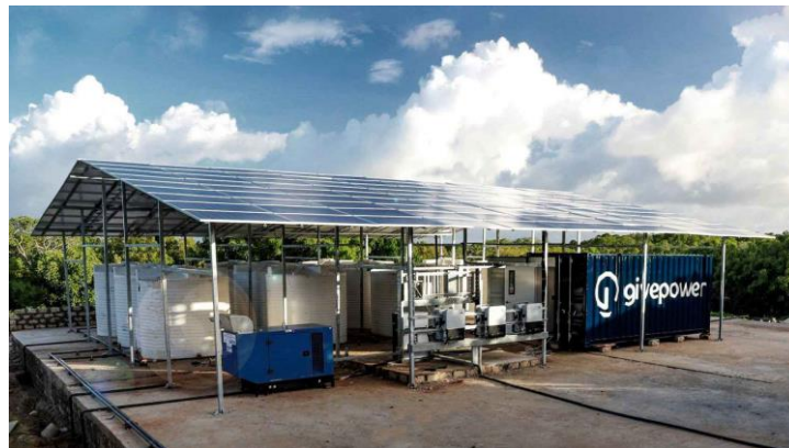
Figura 5: Instalación de Givepower
