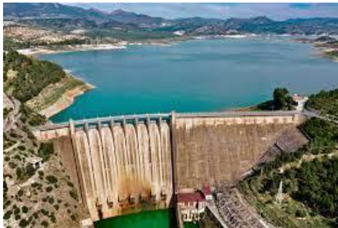
Ilustración 12. Presa de Iznájar
