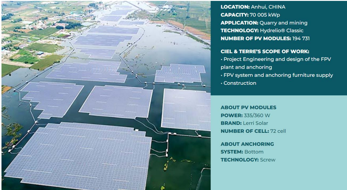
Ilustración 1. Instalación flotante de 70 MW en Anhui, China
