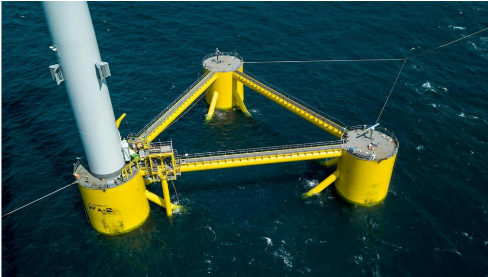
Figura 3: Subestructura flotante WindFloat T (Fuente: Principle Power, 2024)
