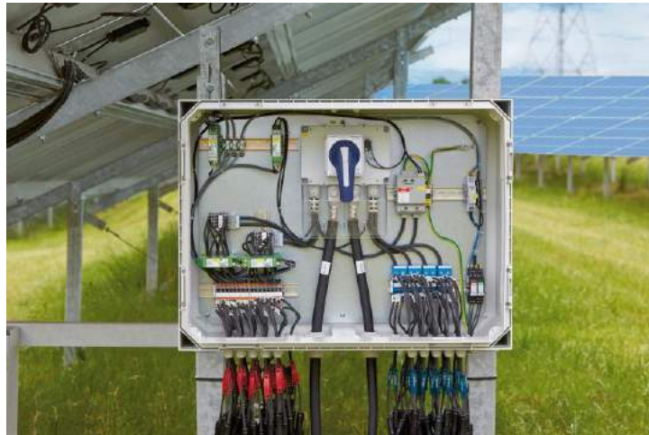
Ilustración 12. Ejemplo de string box. (Fuente: Mecatron Solar).
