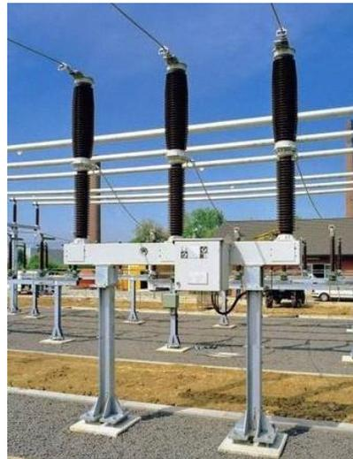
Figura 43: Ejemplo de interruptor de potencia en subestación [19]
