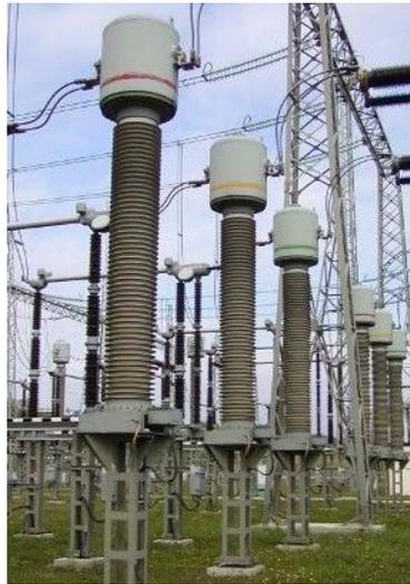
Figura 44: Ejemplo de transformadores de intensidad en subestación [20]
