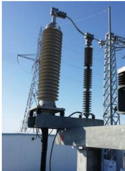
Figura 47: Autoválvula en subestación [23]
