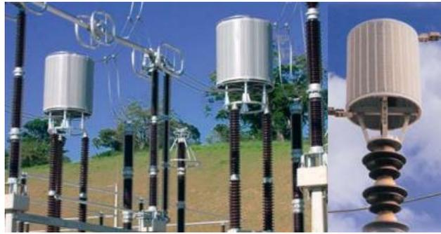
Figura 42: Ejemplo de bobinas de bloqueo en subestación [18]
