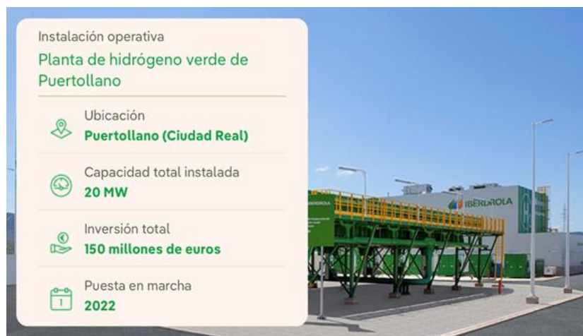
Ilustración 12: Planta Hidrógeno Verde Puertollano (Iberdrola).
