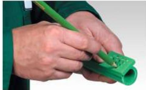
Marcar la profundidad de soldadura con galga
