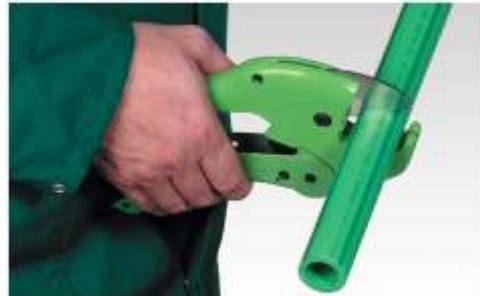
Cortar la tubería
