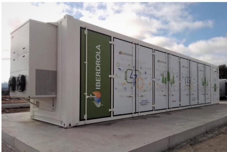
*Figura 18 - Batería ion-litio en instalación solar fotovoltaica (Iberdrola, 2021c)*
