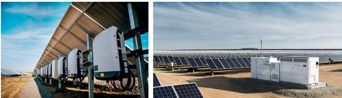
*Figura 17 - Inversor solar en cadena (izquierda) y central (derecha) (Ase Renovables S.L., 2021)*
