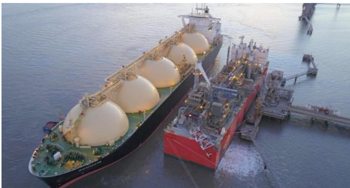
Ilustración 1. Planta de licuefacción de GNL flotante
