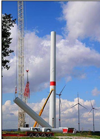
*Ilustración 8: Torre del aerogenerador, en el caso del nuestro de 80 metros*
