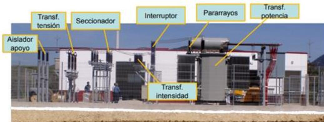
Figura 37. Subestación de tipo convencional
