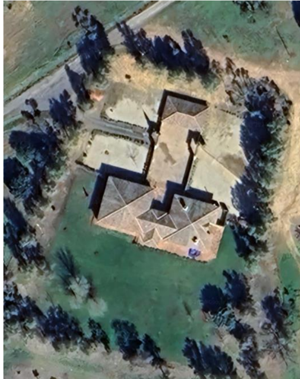
Ilustración 21: Imagen de la casa residencial vista desde arriba. Fuente: Google Earth
