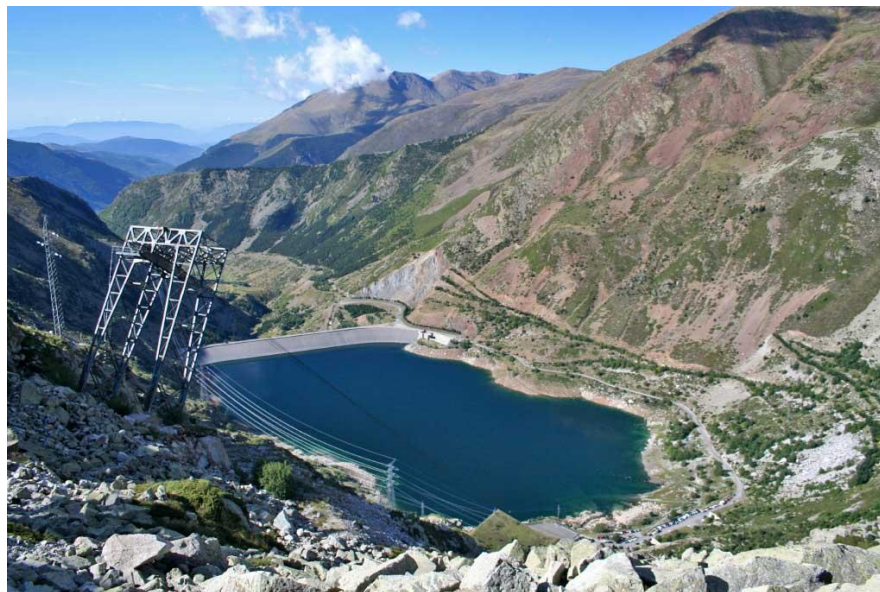
Figura 2.10: Central hidroeléctrica de Sallente en Lleida. (Fuente:[17])
