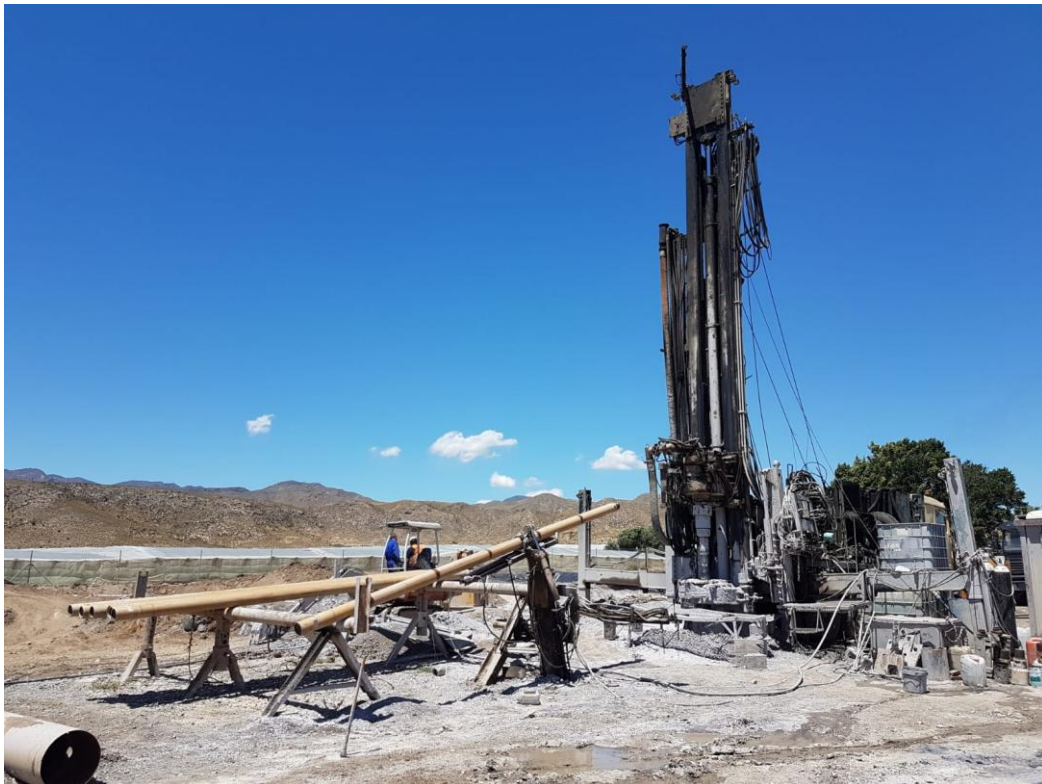
Figura 2.8: Construcción de la planta de geotermia profunda en Níjar, Almería. (Fuente:[13])
