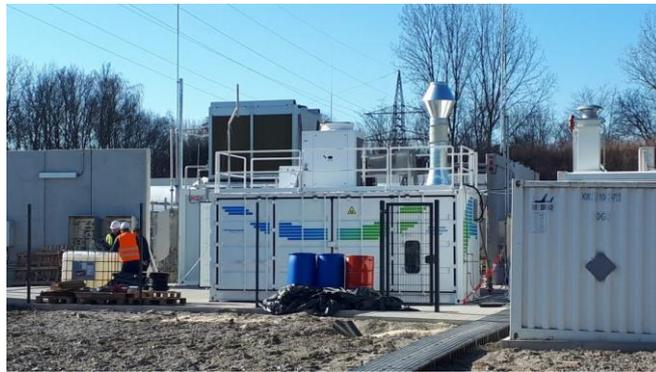
*Figura 61: Compresor de hidrogeno verde hiperbaric. Fuente: Hiperbaric*
