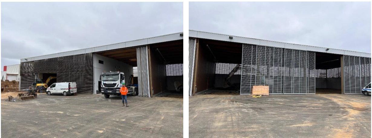
Ilustración 26. Base de mantenimiento en construcción
