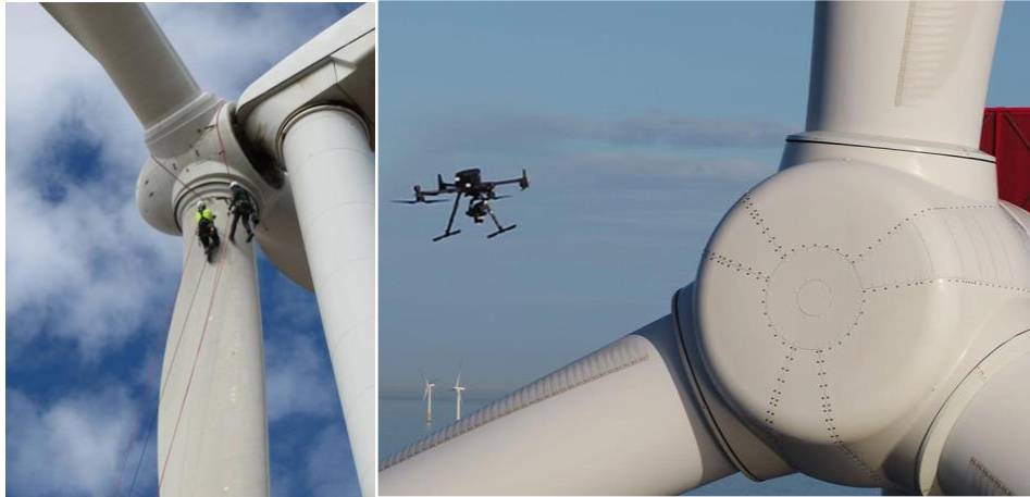
Ilustración 23. A la izquierda, ilustración de un técnico de trabajos verticales trabajando en una pala y a la derecha de un dron que está inspeccionando.
