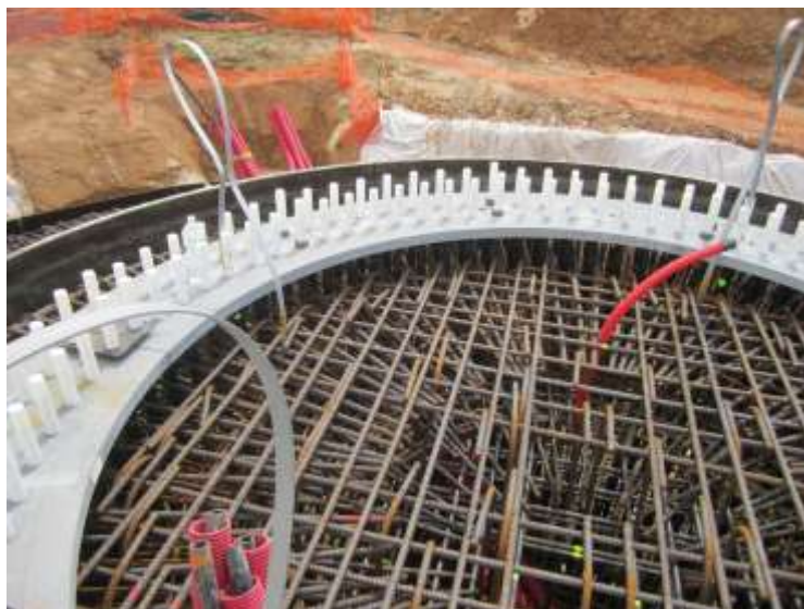
Figura 18. Vista red puesta a tierra pre-cimentación [Maltep]
