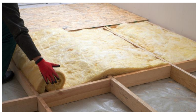
Figura 24: Ejemplo de aislamiento encima del forjado
