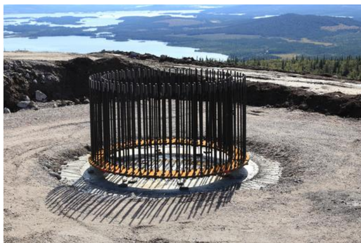
Figura 15: Cimentación del aerogenerador tipo pernos de anclaje
