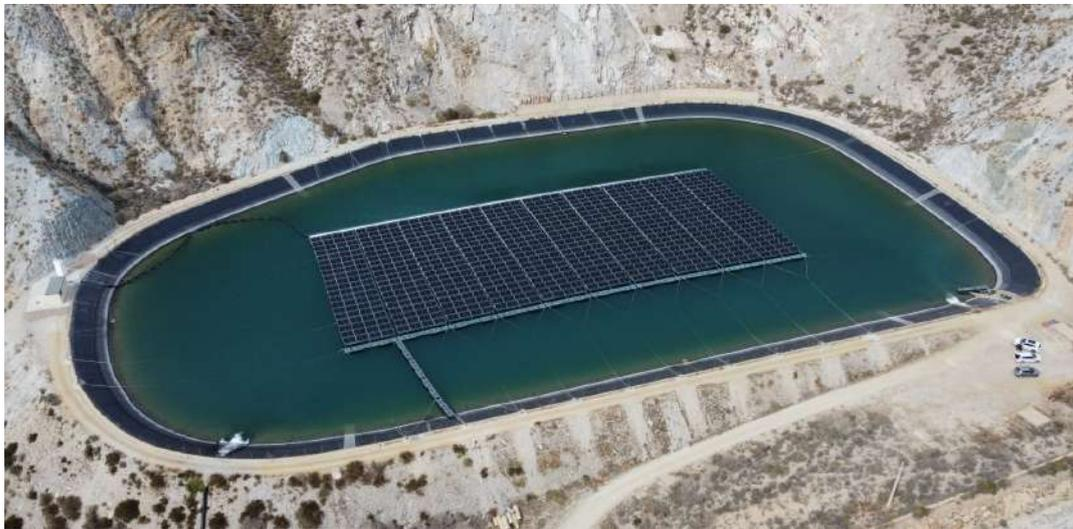
Figura 7.1. Instalación de fotovoltaica flotante en la balsa de Abellán (Fuente: Ministerio de Agricultura, Pesca y Alimentación)
