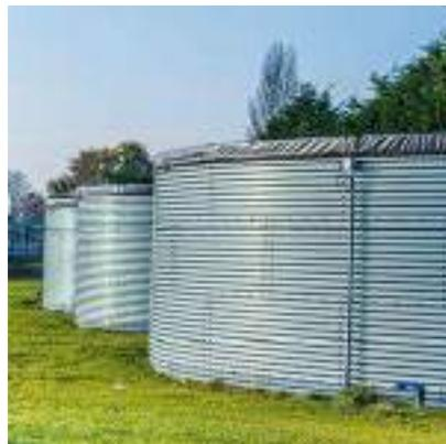
*Figura 15. Depósitos de almacenamiento de purines (Genap)*
