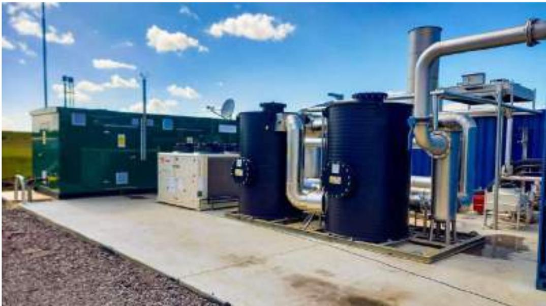
*Figura 28. Sistema de upgrading PurePac*
