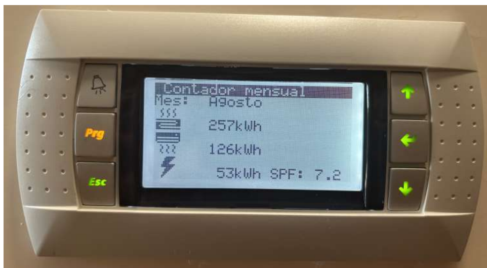
Figura 7.19: Datos acumulados del mes actual (agosto) registrados por el contador de la bomba de calor geotérmica. Fuente: Elaboración propia.
