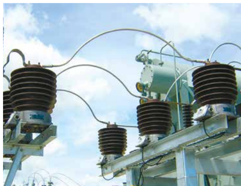
> Transformadores de intensidad (CR) de 36 kV. Electronet Services (Nueva Zelanda).
