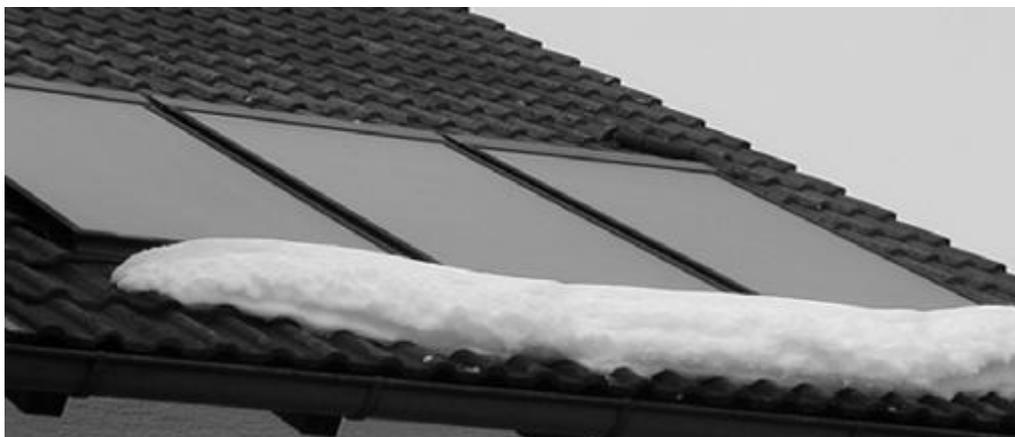
*Figura 7. Captadores solares de placa plana bajo el efecto de la nieve y hielo [1]*
