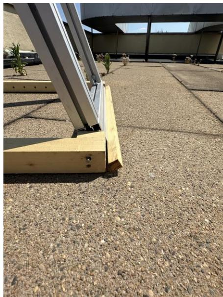
*Figura 23. Madera para evitar el contacto del panel con el suelo*
