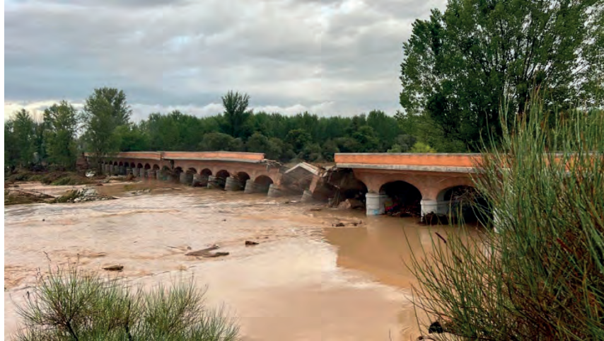
Figura 2: Puente destruido en Aldea del Fresno
