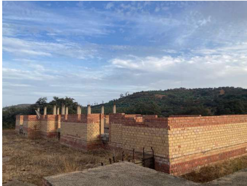
Figura 13: Fotografía de la edificación existente. Elaboración propia (2025)
