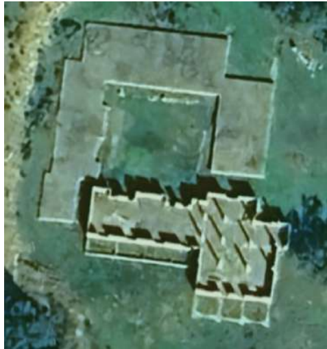
Figura 5: Vista aérea de la edificación. Elaboración propia mediante Google Earth (2025)
