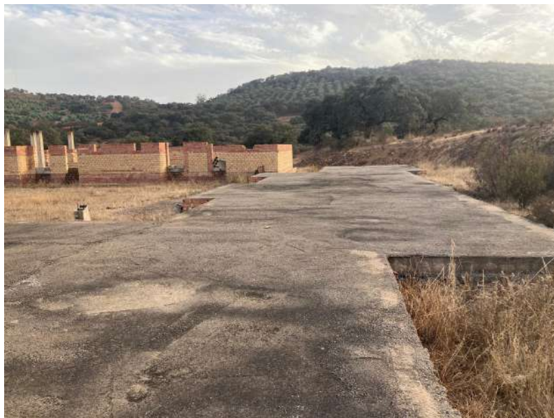
Figura 14: Fotografía de la edificación existente. Elaboración propia (2025)
