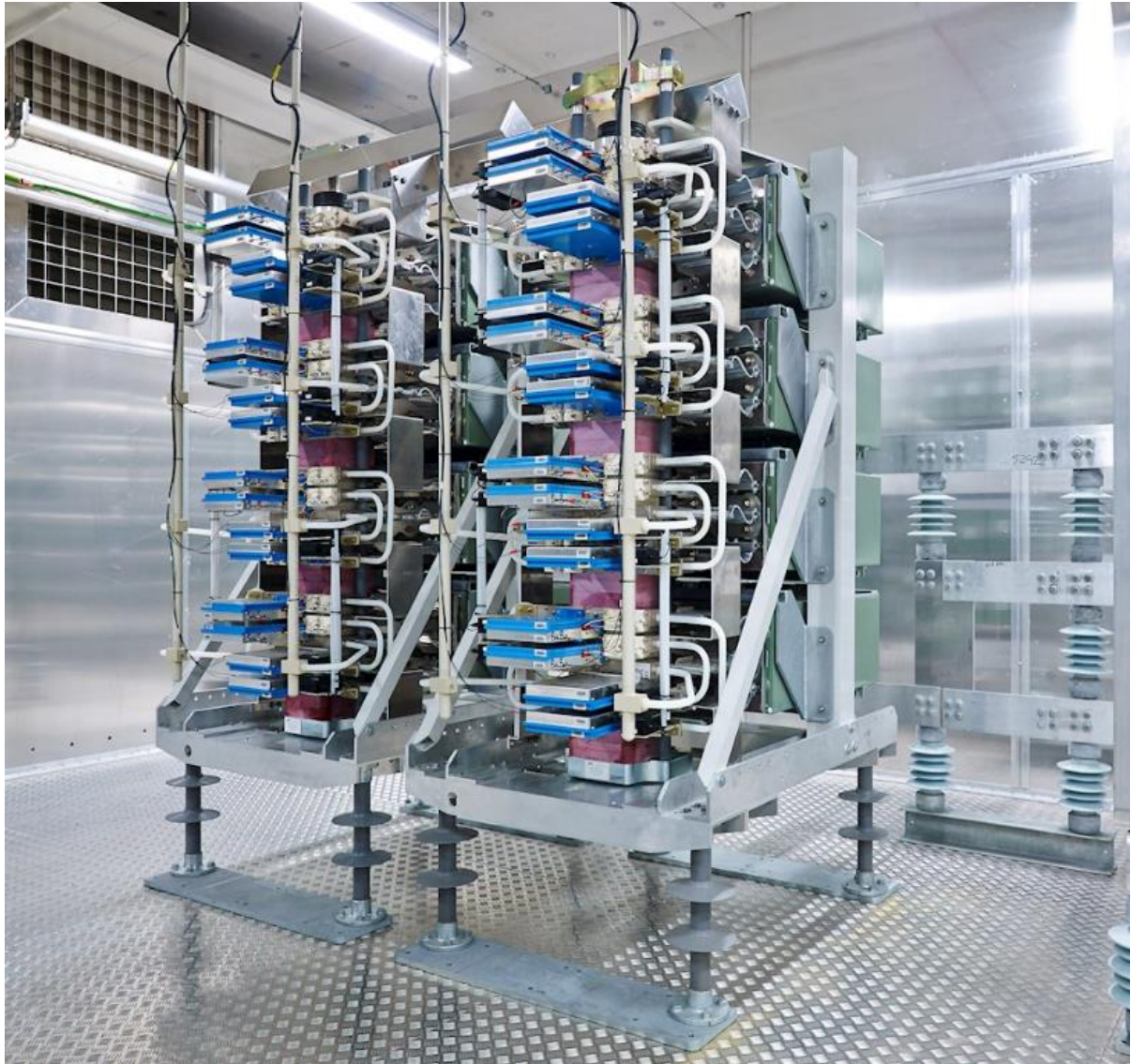
Ilustración 49 STATCOM Hitachi (Energy News, s. f.)
