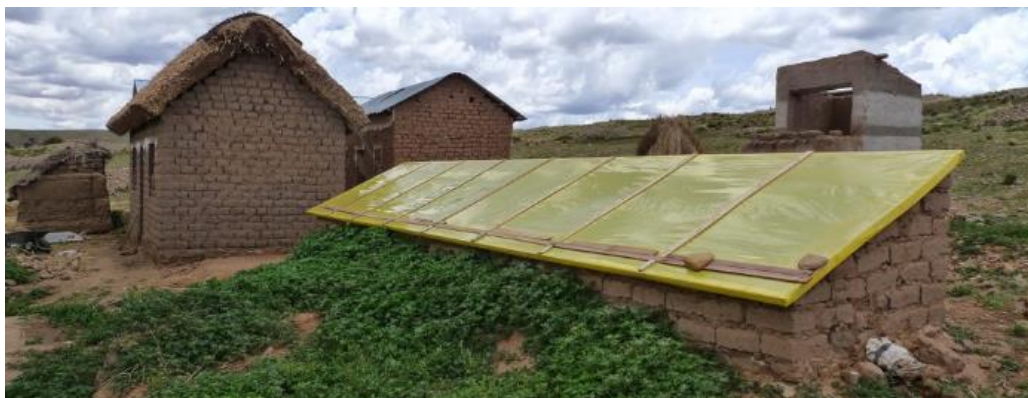
Ilustración 20: Aclimatación de un biodigestor en Ecuador (~4000 m.s.n.m)
