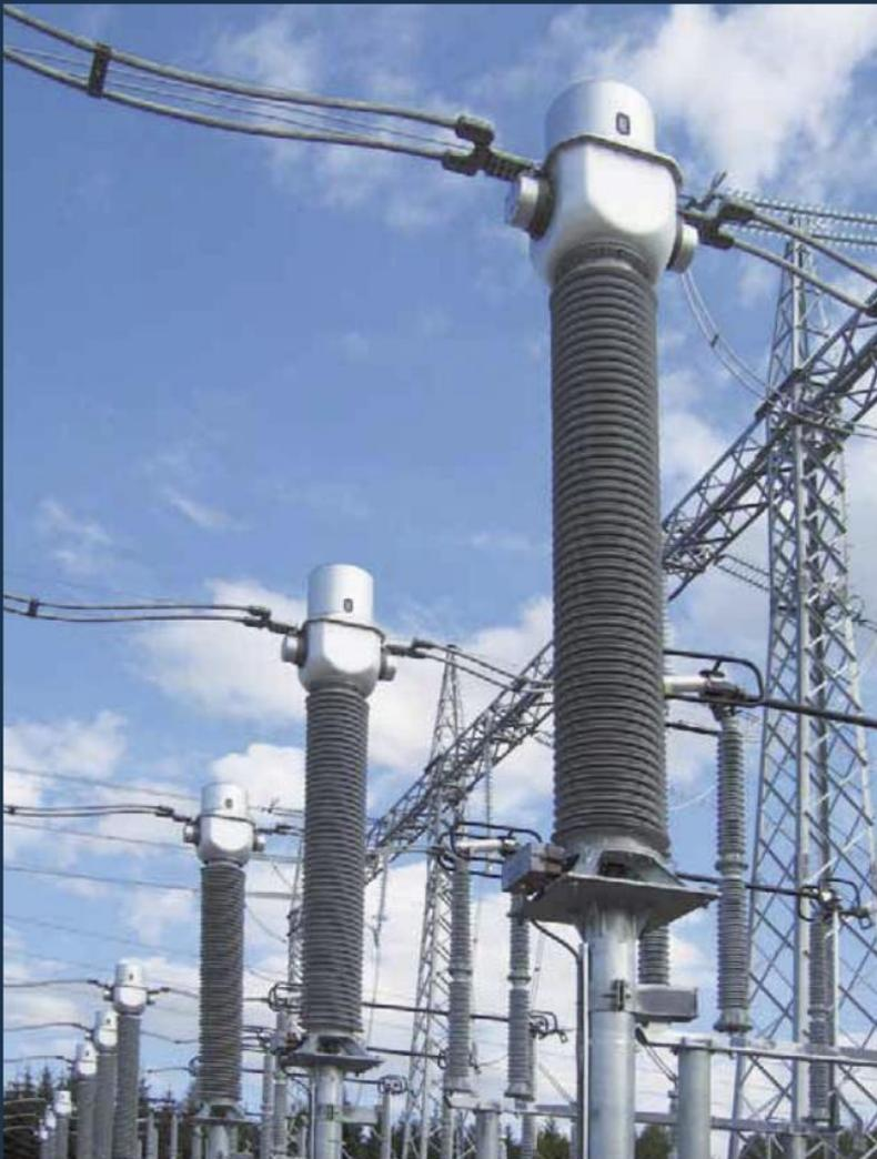
› Transformadores de intensidad de 420 kV con aislamiento de silicona gris. Statnett (Noruega).
