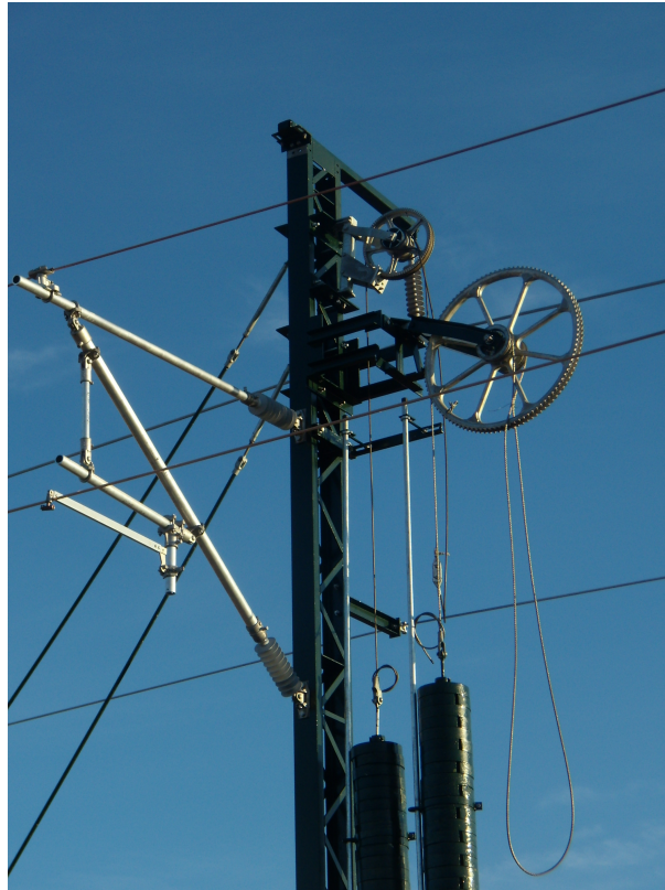
Figura 2.6: Sistema de compensación mecánica.
