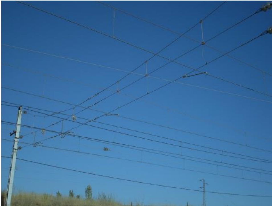
Figura 10. Pórtico Funicular
