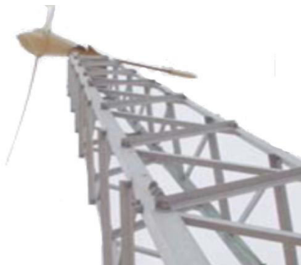
Figura 8. Aerogenerador tipo Torre de Celosía.
