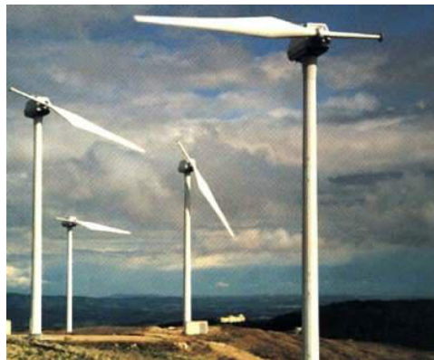
Figura 5. Aerogenerador tipo Monopala.
