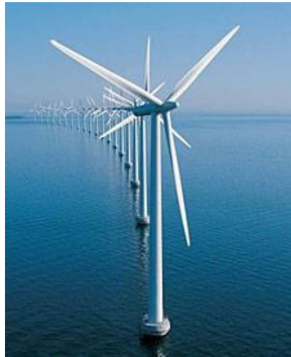
Figura 3. Aerogenerador tipo Tripala.
