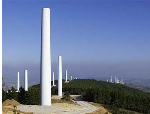
Figura 9. Aerogenerador tipo Torre Tubular.
