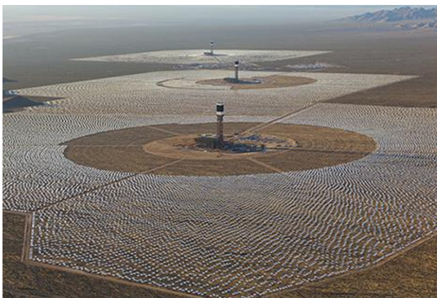
Figura 9. Vista aérea de las tres torres del proyecto Ivanpah.
