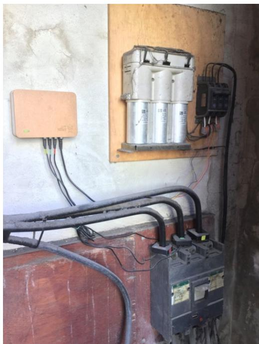
Imagen 13. Fotografía del medidor de GreenAnt instalado correctamente
