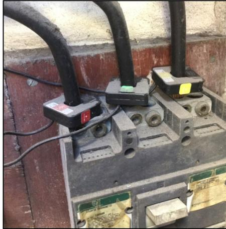
Imagen 11. Fotografía de los transformadores de corrientes una vez instalados.
