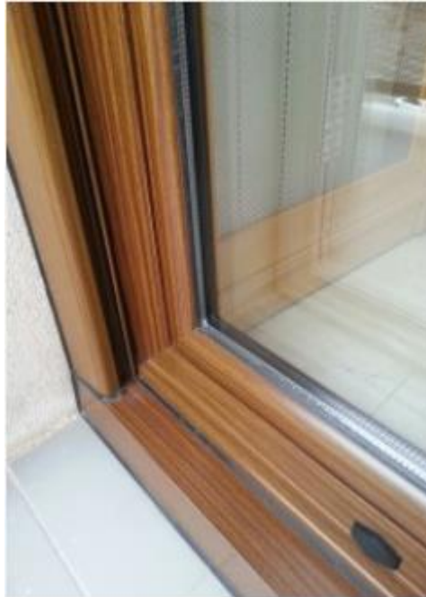
Figura 17. Sellado de una ventana con silicona.
