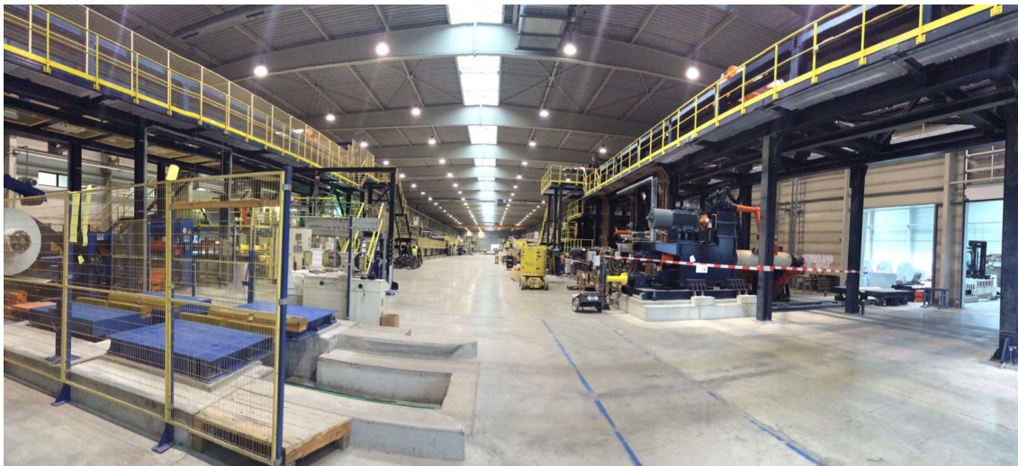
Figura 3 Fábrica de Coil previa instalación de la línea 6
