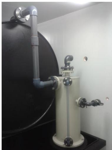
*Figura 10. Detalle del lavador de gases*
