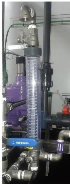
*Figura 24. Detalle de la columna de calibración*
