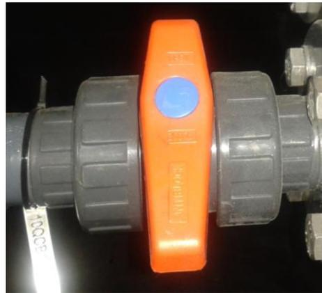
*Figura 30. Detalle de una válvula de bola en PVC*
