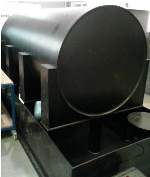
*Figura 8. Detalle del depósito y el cubeto*
