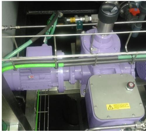
*Figura 15. Detalle de una bomba de la línea de alta presión*
