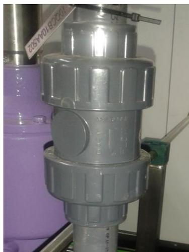
*Figura 31. Detalle de una válvula de retención en PVC*
