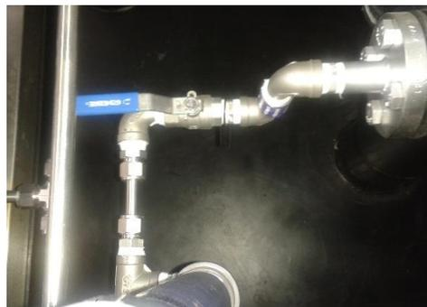
*Figura 11. Detalle de la línea de aspiración*
