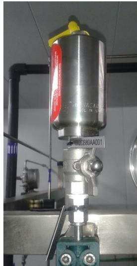
*Figura 20. Detalle de un amortiguador de pulsaciones*
