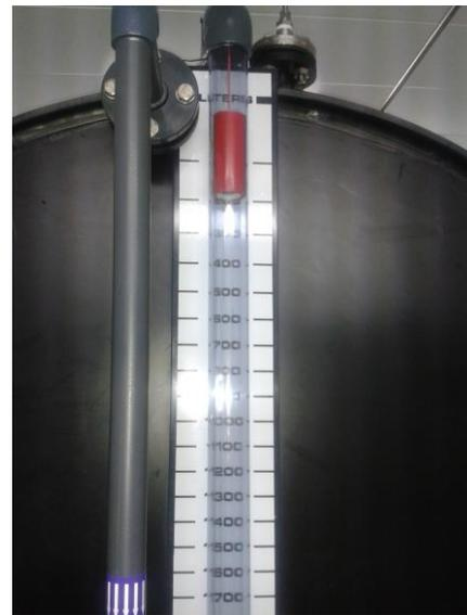
*Figura 9. Detalle del indicador de nivel*
