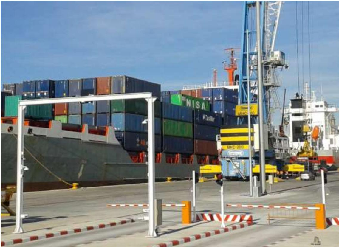
**Figura 5 – Ejemplo de puerta automática con arco equipado con cámaras para la lectura de matrículas. Fuente: InterSagunto Terminales.**
