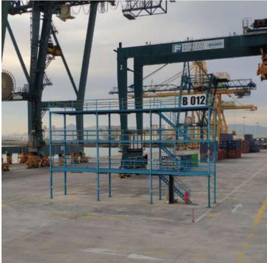
**Figura 8 – Ejemplo de torre para conexión de contenedores frigoríficos. Fuente: IST.**
