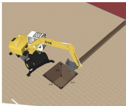
Img.54. Excavación del agujero de la cimentación.
