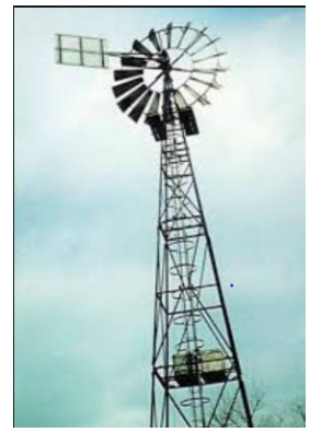
Img.38. Torre de aerogenerador 2.
