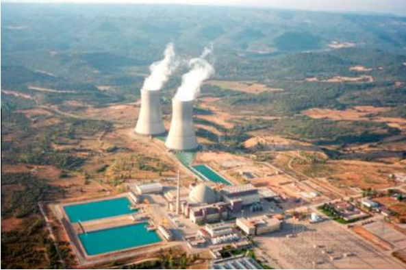
Img.11. Central nuclear de Trillo.
