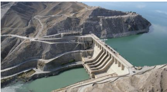
Img.16. Central hidroeléctrica.
