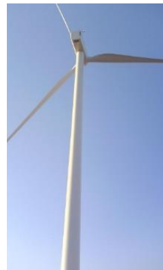
Img.37. Torre de aerogenerador 1.
